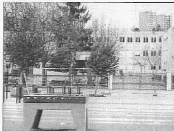
La première tranche des travaux réalisés sur le secteur Nord de Marbé consistait à l'aménagement de l'espace situé entre le collège Schuman et l'école Jean Moulin dont l'entrée sera déplacée de ce côté. Un parvis arboré a été créé. On y distingue les prémices de la coulée verte qui traversera le quartier
