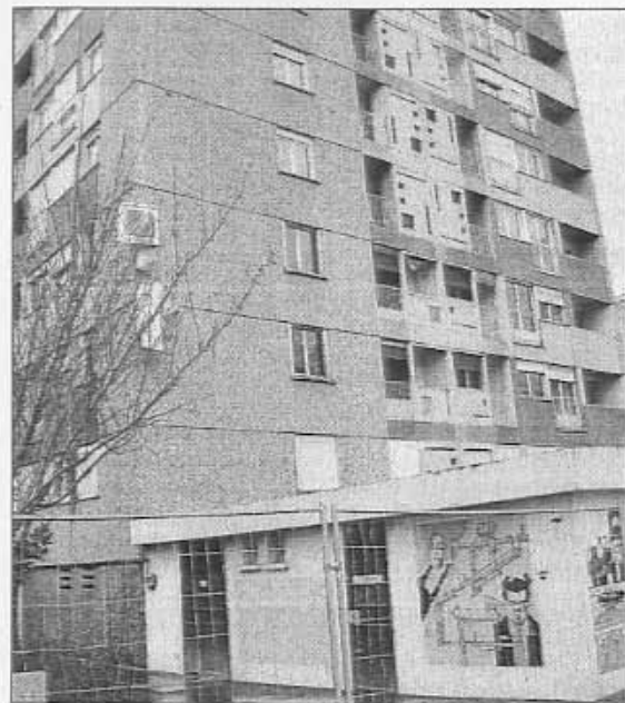
Des barrières de sécurité ont été installées autour des bâtiments 1 Churchill et 2 Schuman. Il va être procédé au nettoyage et à la déconstruction intérieure des tours pour le préparer avant leur démolition
