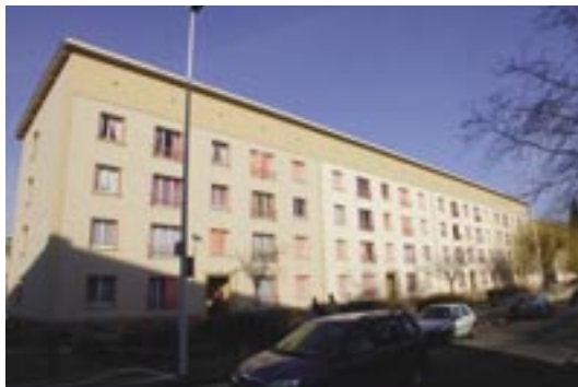
Bâtiment 44 - Rue Mozart
